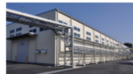
（株）ノダ 富士川工場 （静岡県富士市）
