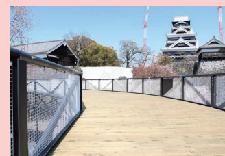
熊本城特別見学通路 (熊本県熊本市)
