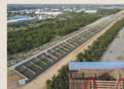
防潮堤 芯材使用状況
