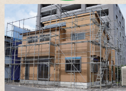
構造用ハイベストウッド(MDF)施工例
